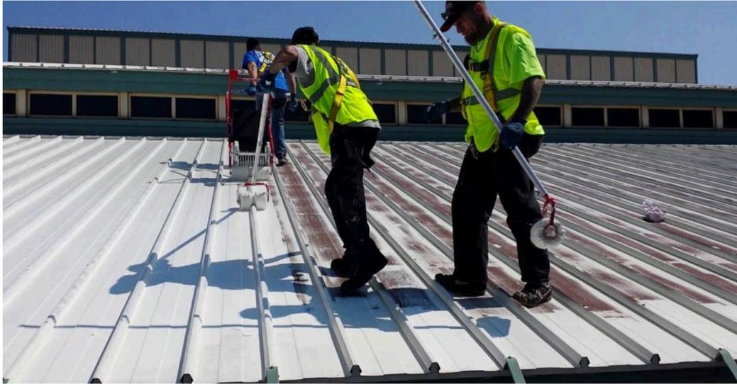
Luvitec ofrece una solución que le dará por mucho tiempo nueva vida al techo, se trata del sistema de **Restauración de techos Metálicos** que comprende la limpieza, reparación y sellado de elementos defectuosos hasta el recubrimiento de la totalidad de la cubierta, remates y canales con un recubrimiento o pintura impermeabilizante.
